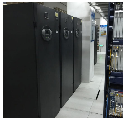
13 узлов внутренних блоков : фильтры, вентиляторы и т.д.
